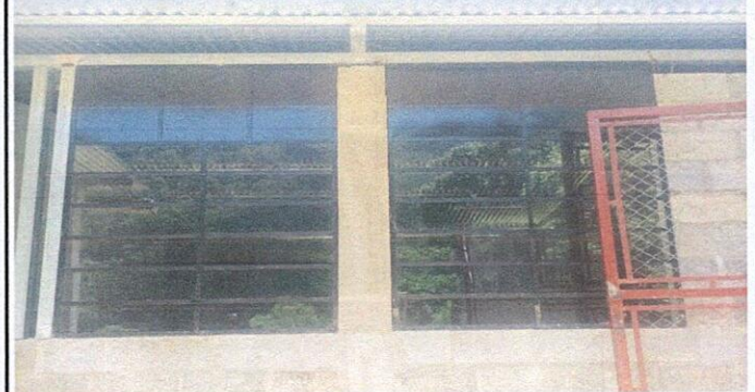
Foto 2: Instalación de ventanas de metal incluye vidrios transparentes
