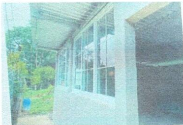
Foto 5: Colocación de puerta y ventanas
