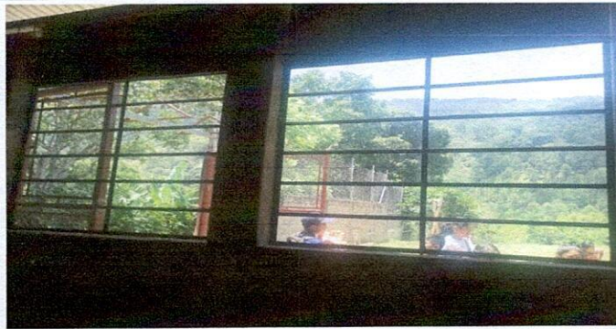
Foto1: Instalación de ventanas de metal incluye vidrios transparentes
