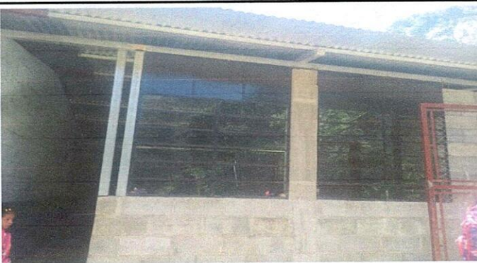
Foto 3: Instalación de ventanas de metal incluye vidrios transparentes
