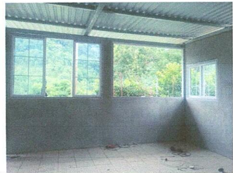
Foto 6: Pintura en paredes
